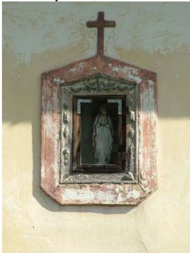
falifülke a „nyugati” homlokzaton
