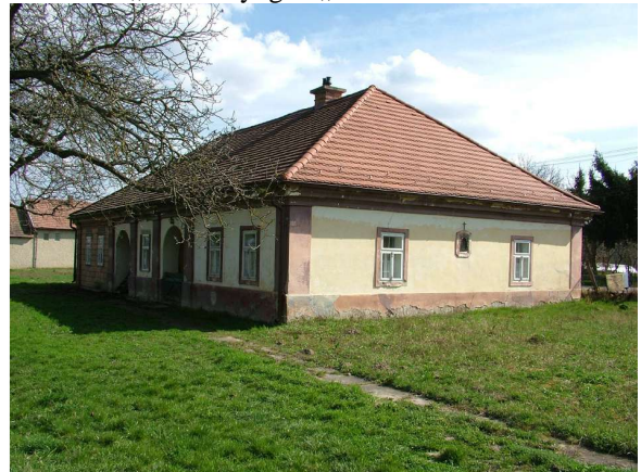
volt kúria „nyugati és északi” homlokzatai
